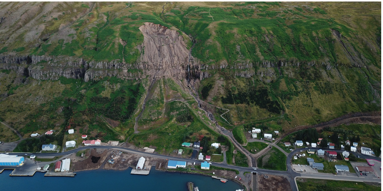
Skriðusvæðið milli Búðarár og Stöðvarlækjar 3. júní 2021 (efri mynd) og september 15. september 2021 (neðri mynd). Sjá má upptök skriðunnar í desember 2020, umfangsmikla varnargarða á skriðusvæðinu sem voru langt komnir í byggingu í júní og hvernig gróður hefur náð að hylja skriðusvæðið í september. (Ljósmyndir: Jón Kristinn Helgason).
